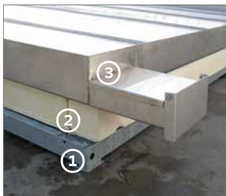
1 サポートフレーム 2 断熱パネル 3 排水溝入り槽
